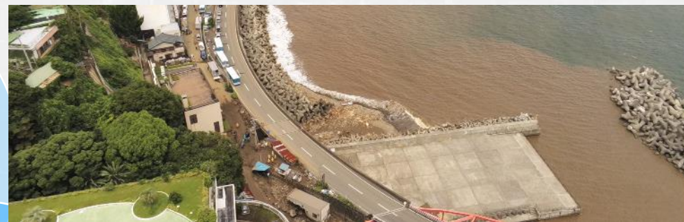
熱海市伊豆山土石流 災害支援 | 2021年7月
