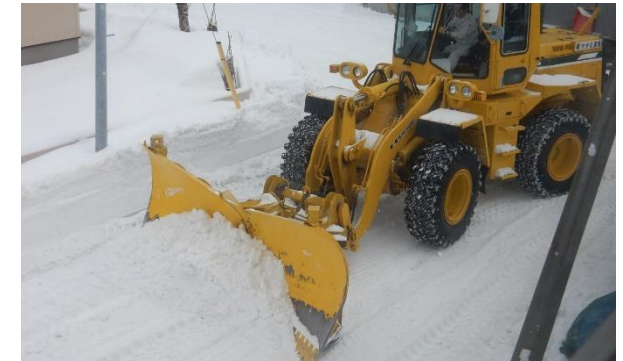
降雪時は除雪車を用いて早期復旧が可能
